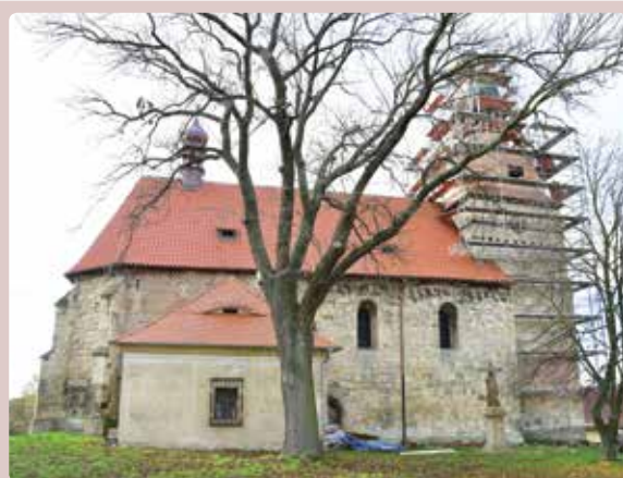
LIBČEVES - obnova střechy kostela
