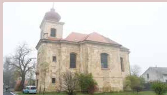
REJŠICE - obnova střechy kostela
