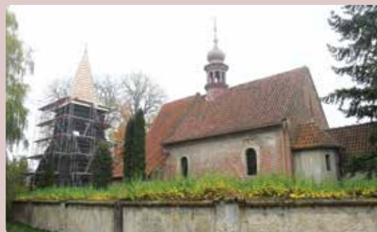
JABKENICE - obnova střechy zvonice
