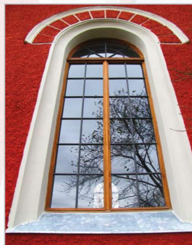
Detail okna kaple Panny Marie Karmelské ve Vlčí Hoře
