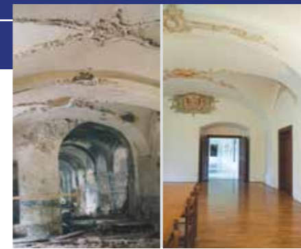
Refektář před a po rekonstrukci
