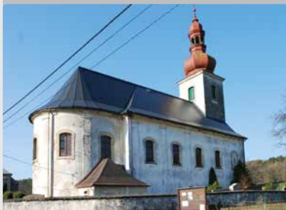
Vikariát liberecký: Zdislava, kostel sv. Jana Křtitele - obnova střechy
