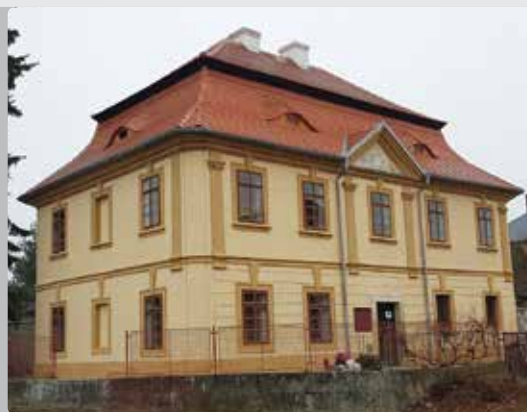
Vikariát českolipský: Jitřava, fara - obnova fasády
