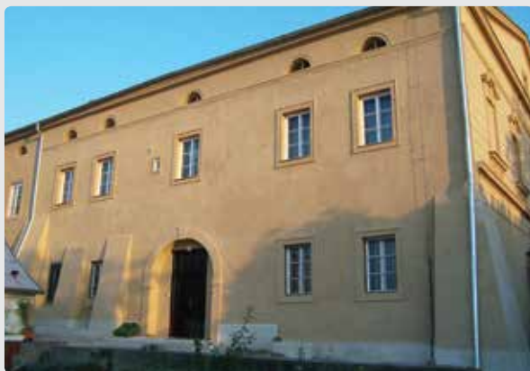
Biskupství: Litoměřice, kanovnické domy - obnova fasád zadních traktů
